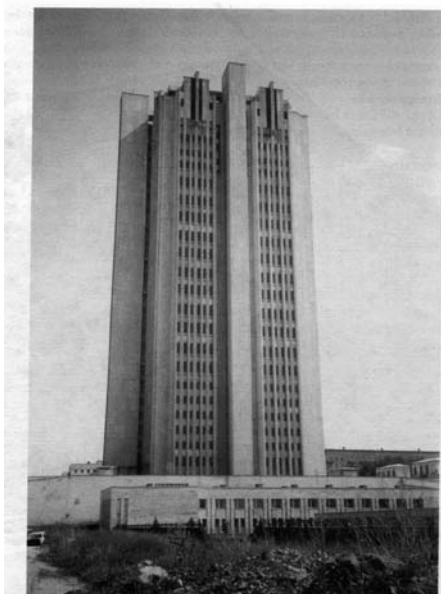
Obr.: Budova luštitecké služby v Moskvě
