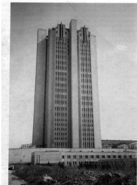
Obr.: Budova luštitecké služby v Moskvě
